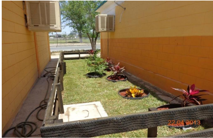
Figura 3.- Bardas perimetrales de separación de jardines
