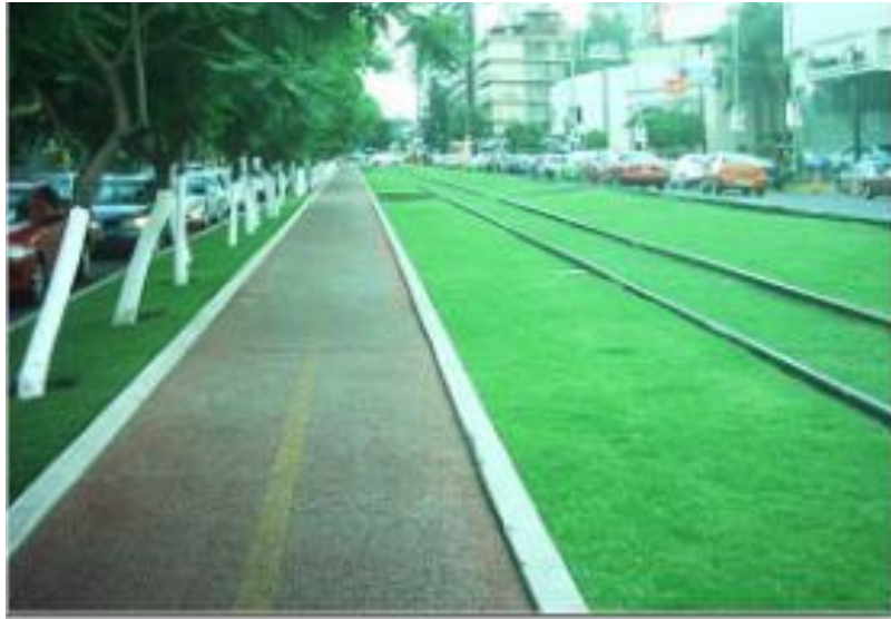
Figura 17.- Pista fabricada con Ecoasfalto
