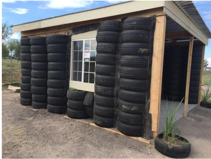
Figura 9.- Construcción de casas
