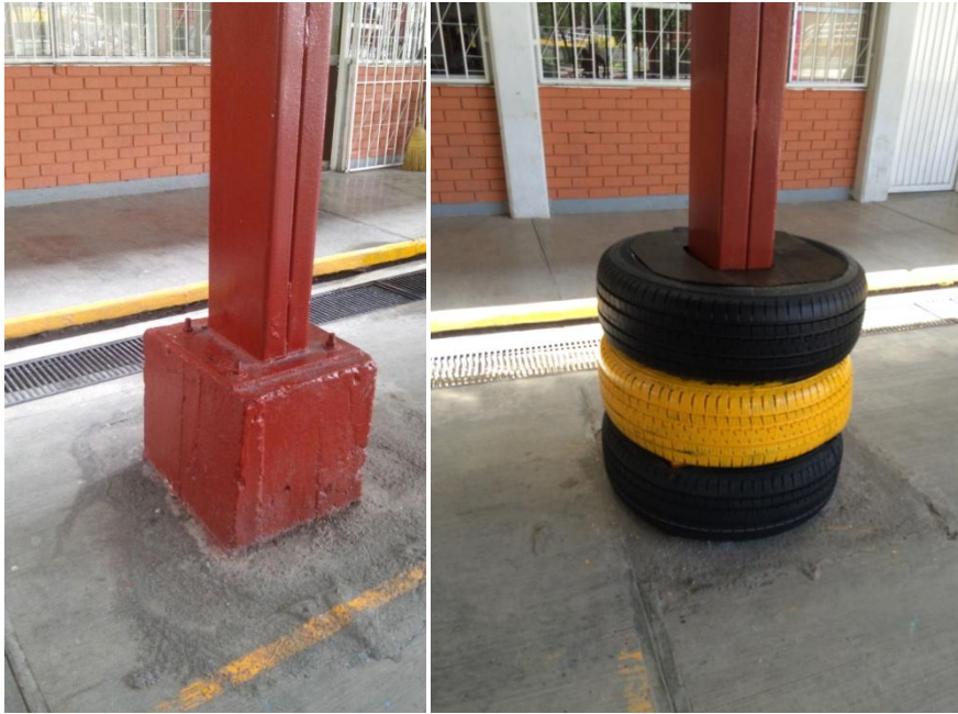
Figura 11.- Protección de columnas en escuelas
